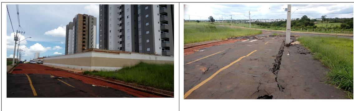
Figura 5: Infraestrutura de asfalto prejudicada pelo alto volume e fluxo da água pluvial
